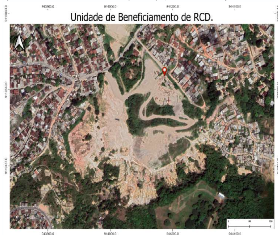
Figura 53: Usina de Beneficiamento de Resíduos de Construção e Demolição (RCD) localizada em Camaragibe/PE
