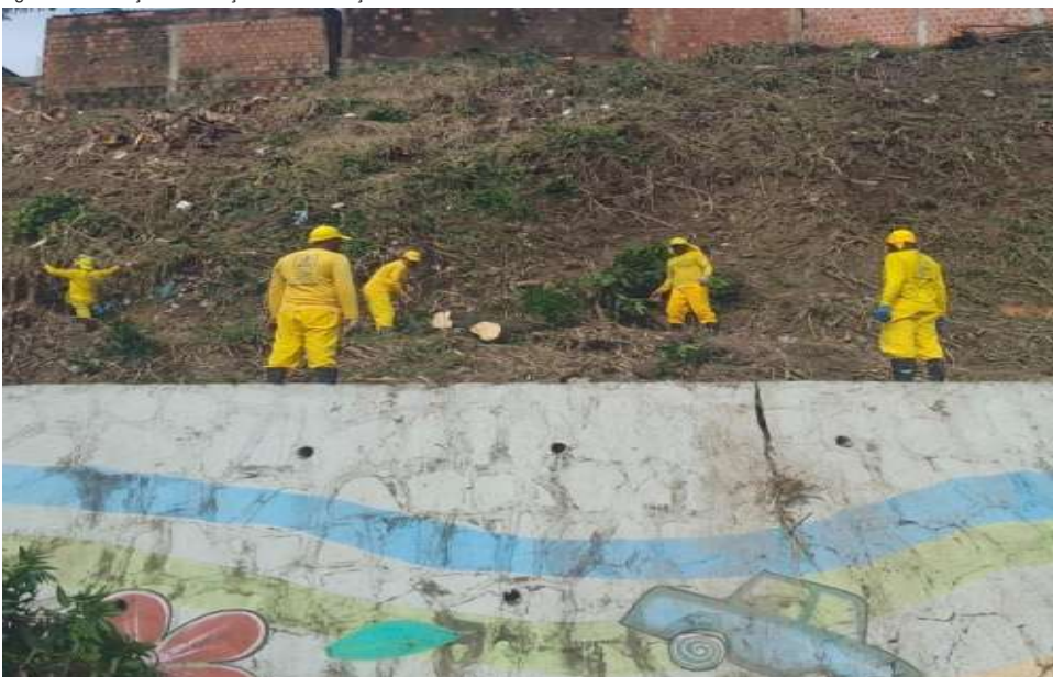
Figura 16: Execução de serviços de manutenção em Recife – PE
