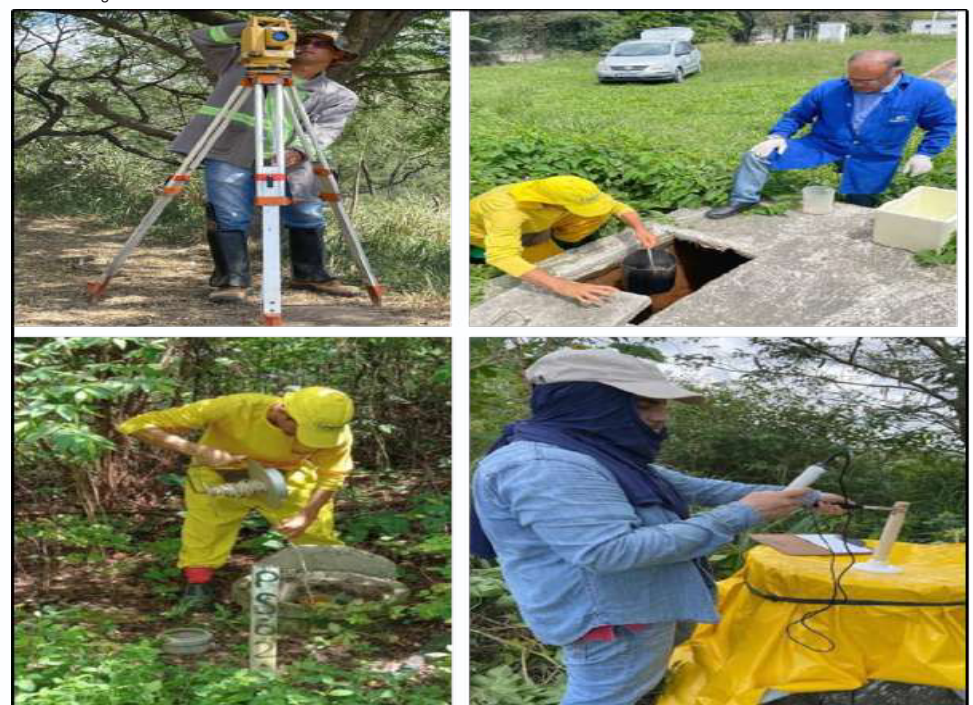
Figura 65: Atividades para a recuperação, monitoramento ambiental e manutenção do aterro encerrado da Muribeca: (a) leitura dos marcos superficiais; (b) coleta de amostra dos lixiviados; (c) inspeção dos poços de águas subterrâneas; e (d) medição concentração e vazão de biogás
